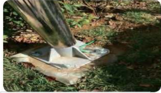
- 옥외 CCTV 카메라 및 폴대에 접지케이블 시공
