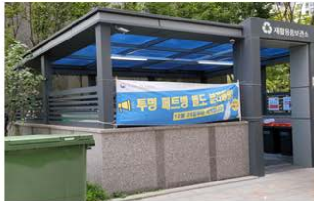
(재활용보관소 CCTV 추가 설치)
